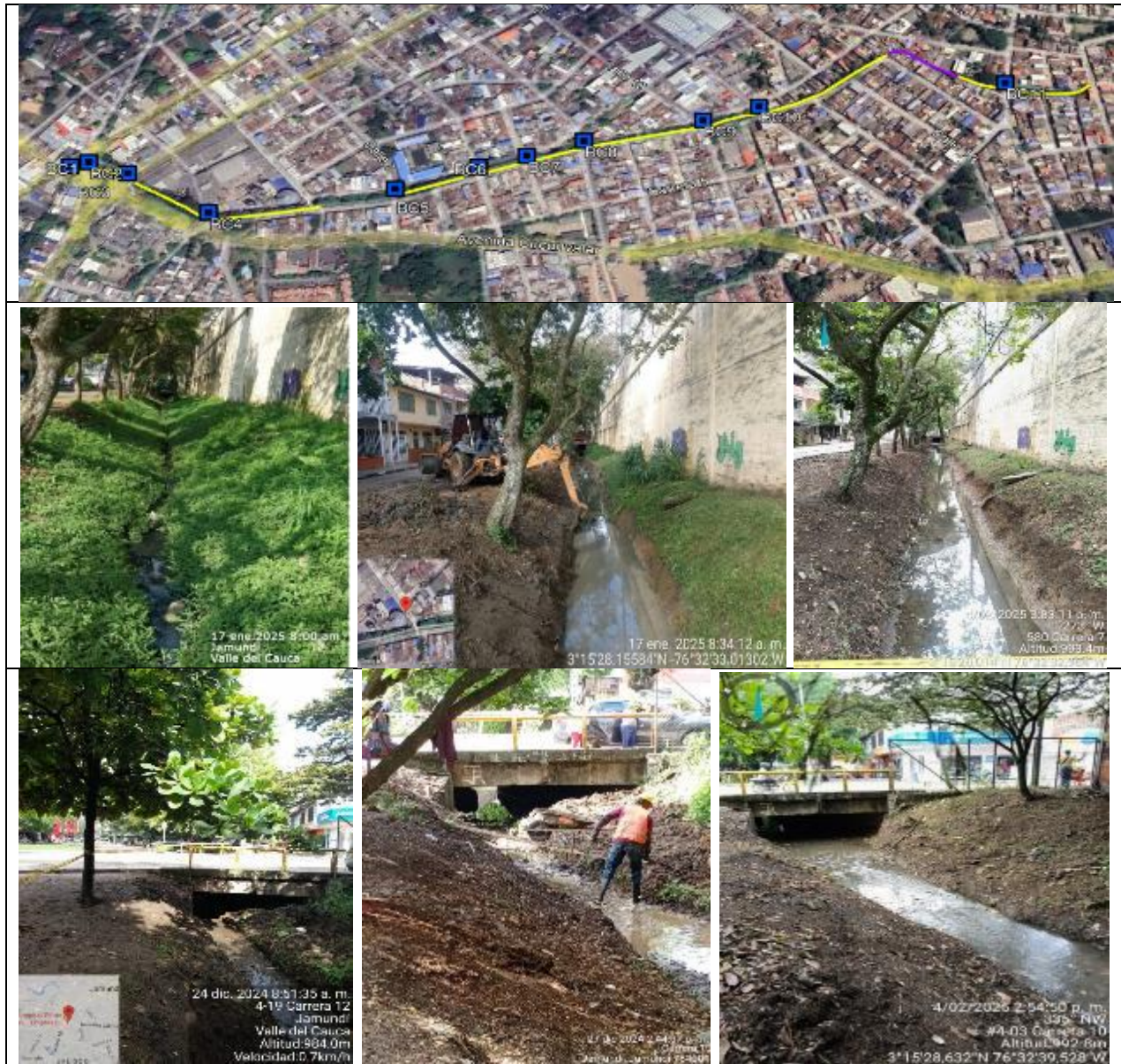
Tramo priorizado y evidencia de la ejecución del contrato No 34-14-08-1162 de 2024
