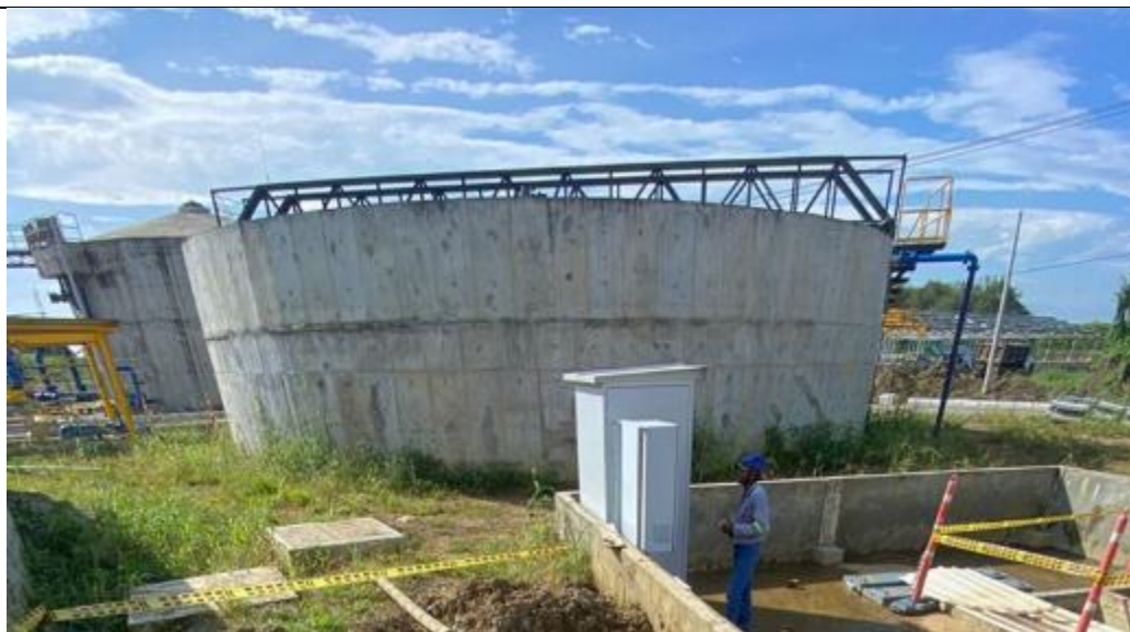
Espesador de lodos y EBAR de lodos
